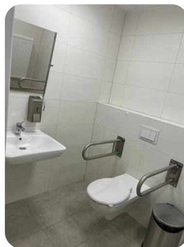
Sanitariat po modernizacji
