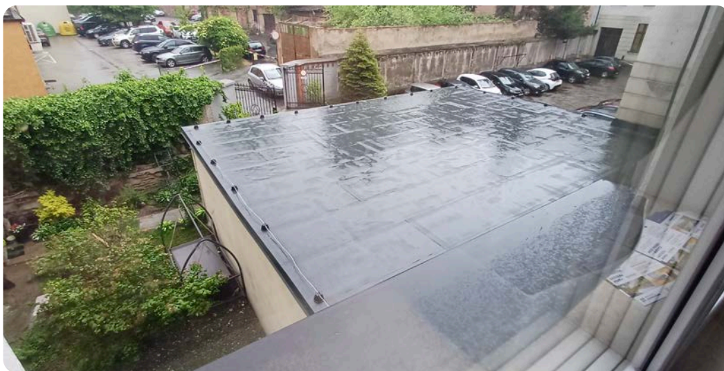
Dach po naprawie
