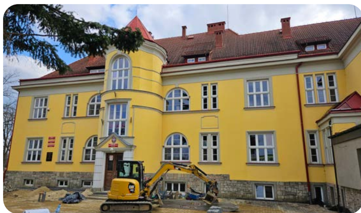
Sprzęt budowlany przed budynkiem szkoły
