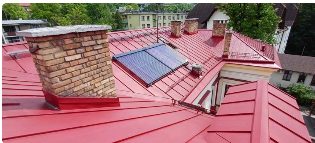
Fragmenty wyremontowanego dachu
