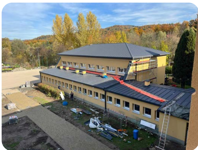
W trakcie prac termomodernizacyjnych
