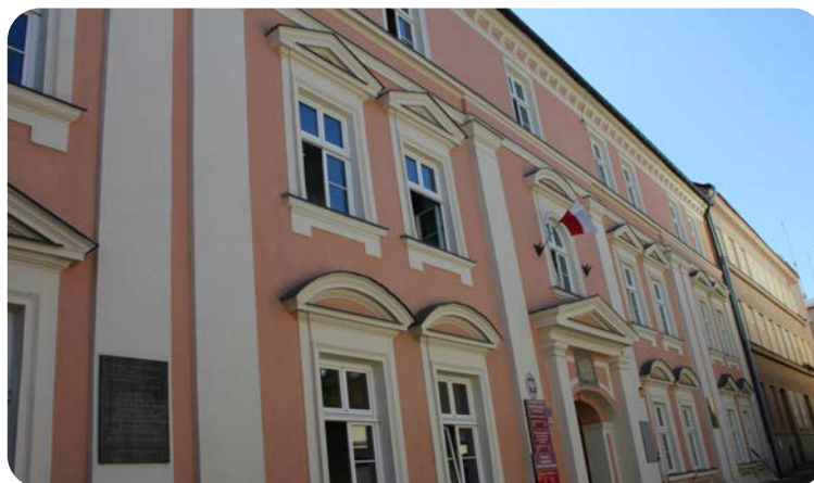
Budynek przy ul. Szerokiej
